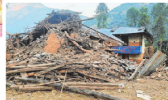
Das Erdbeben hat Tausende Häuser dem Erdboden gleichgemacht.
